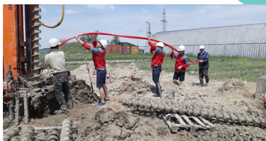
Сооружение грунтового теплового аккумулятора
